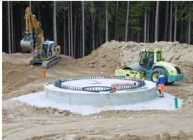
05.10.2015 Das Fundament ist fertig, die Baugrube ist aufgefüllt
