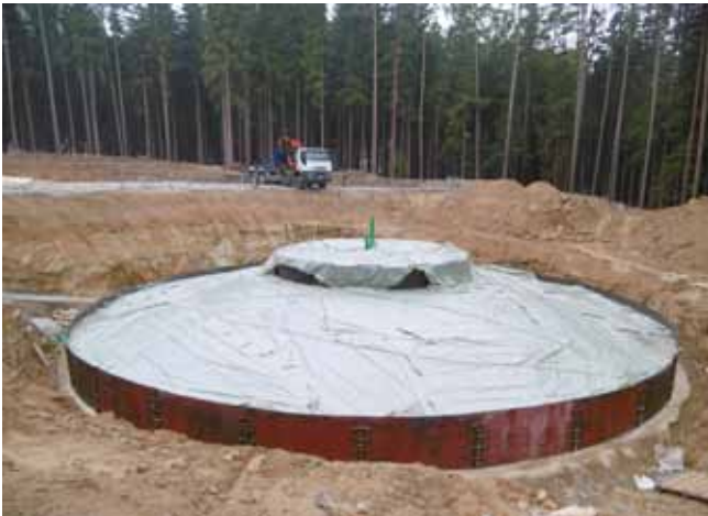
11.09.2015 Gegossenes und geschaltes Fundament
