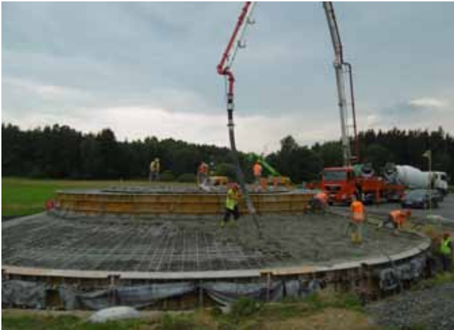
25.07.2016: Betonage des Fundamentes
