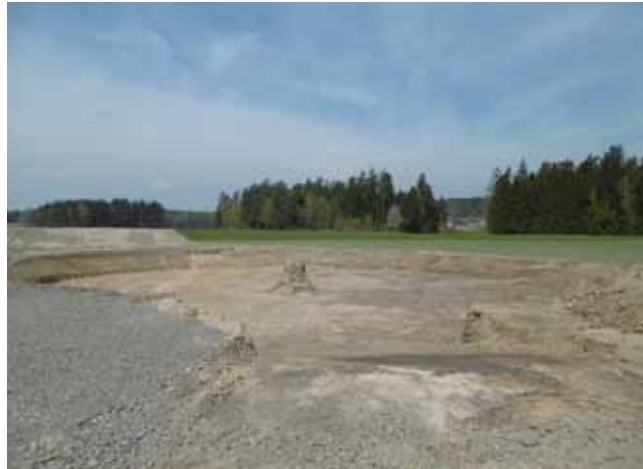
03.05.2016: damit die WEA gerade steht: Vorbereitung der Fundamentsohle (WEA 4)
