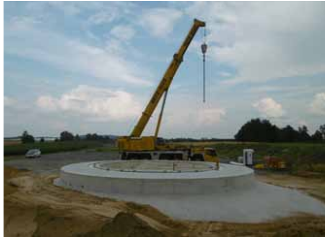
25.07.2016: Hier wird die Baugrube gerade verfüllt (Standort WEA 3)
