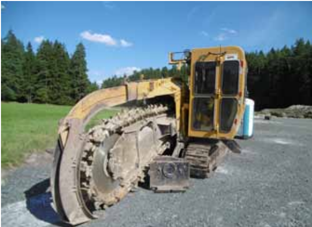
16.08.2016: Grabenfräse zum Bau der Kabeltrasse zwischen WEA 1 und WEA 2
