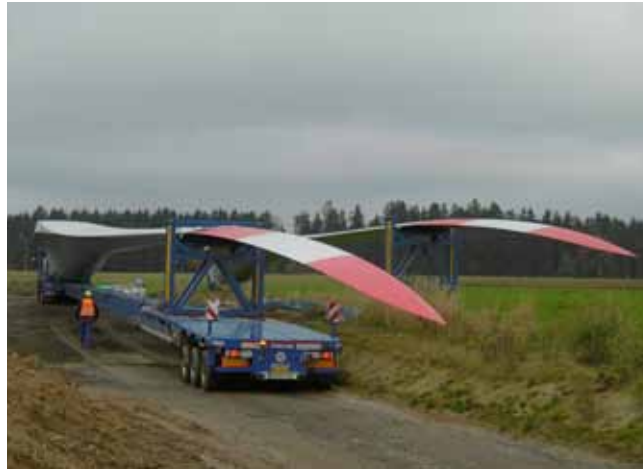
08.11.2016: Die Rotorblätter liegen zum Hochziehen bereit
