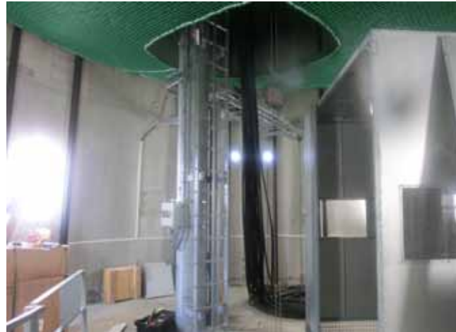
20.10.2016: Blick ins Innere der Anlage: Die Vorberei- tungen für den Innen- ausbau laufen
