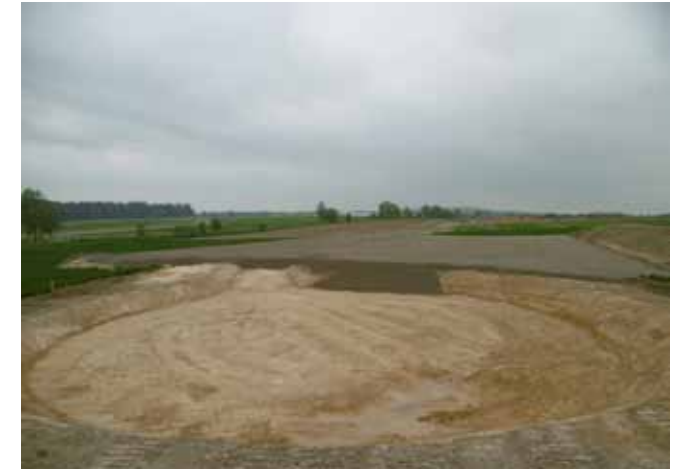
12.05.2016: fertiggestelltes Oberflächenplanum für das Fundament der WEA 3
