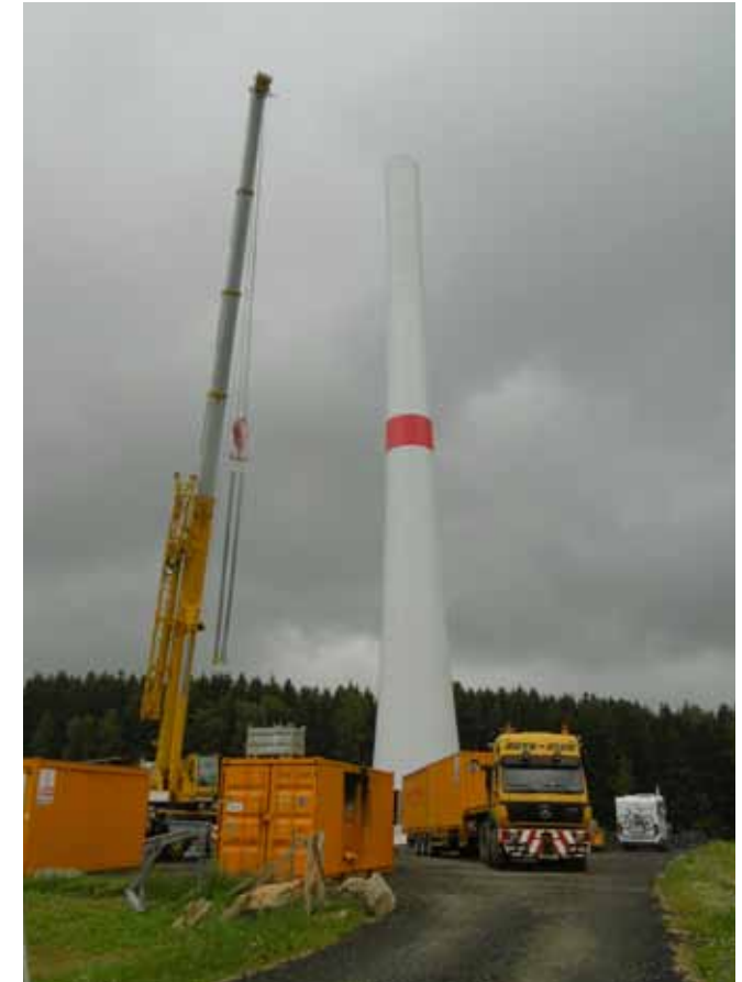
09.08.2016: Die Baustelle zieht weiter zum Standort WEA 4
