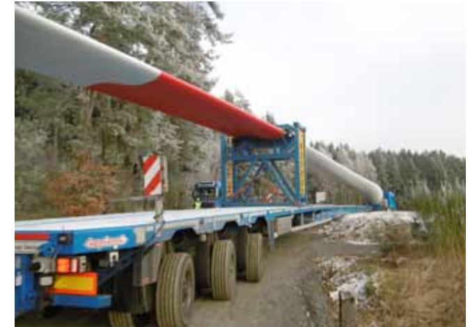
22.12.2016: Kurz vor Weihnachten: Die letzte Anlage (WEA 1) wird erst im Januar 2017 fertig errichtet
