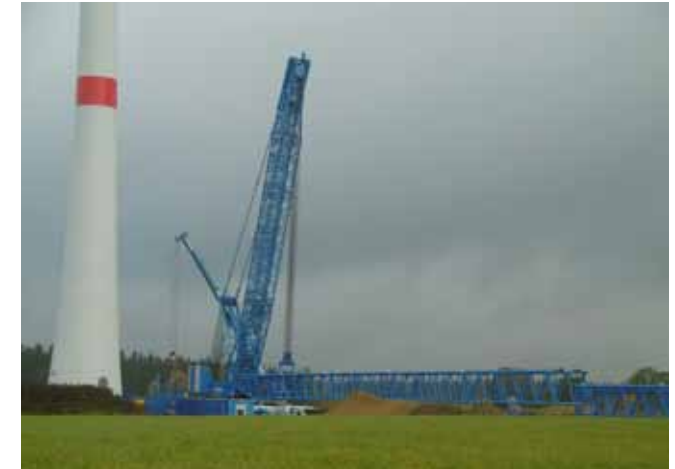
21.10.2016: Montage des Großkrans am Standort der WEA 4
