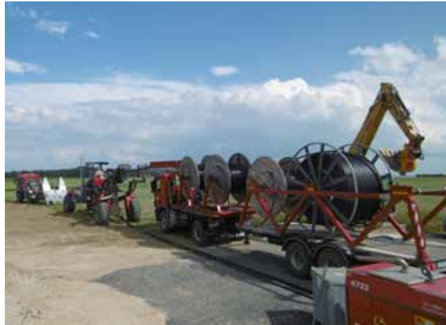
29.08.2016: für einen Großteil der Stromleitung kommt der Kabelpflug zum Einsatz
