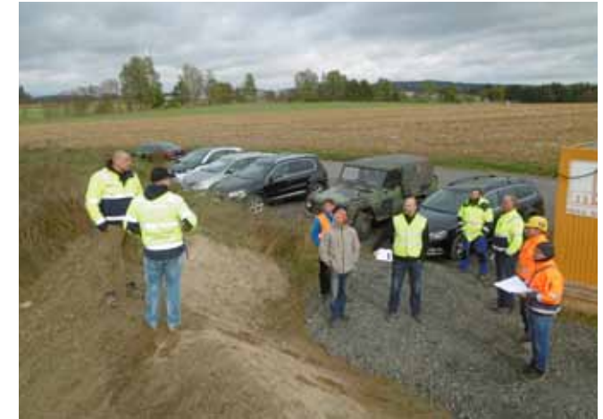
05.10.2016: Site-Kick-Off vor Anlieferung der Großkomponenten mit den Verantwortlichen aller beteiligten Firmen: Nordex - Anlagenhersteller Ostwind - Generalunternehmer Max Bögl - Infrastrukturbau Rostock-Trans - Logistiker Felbermayr - Kran ZEF - Windparkbetreiber
