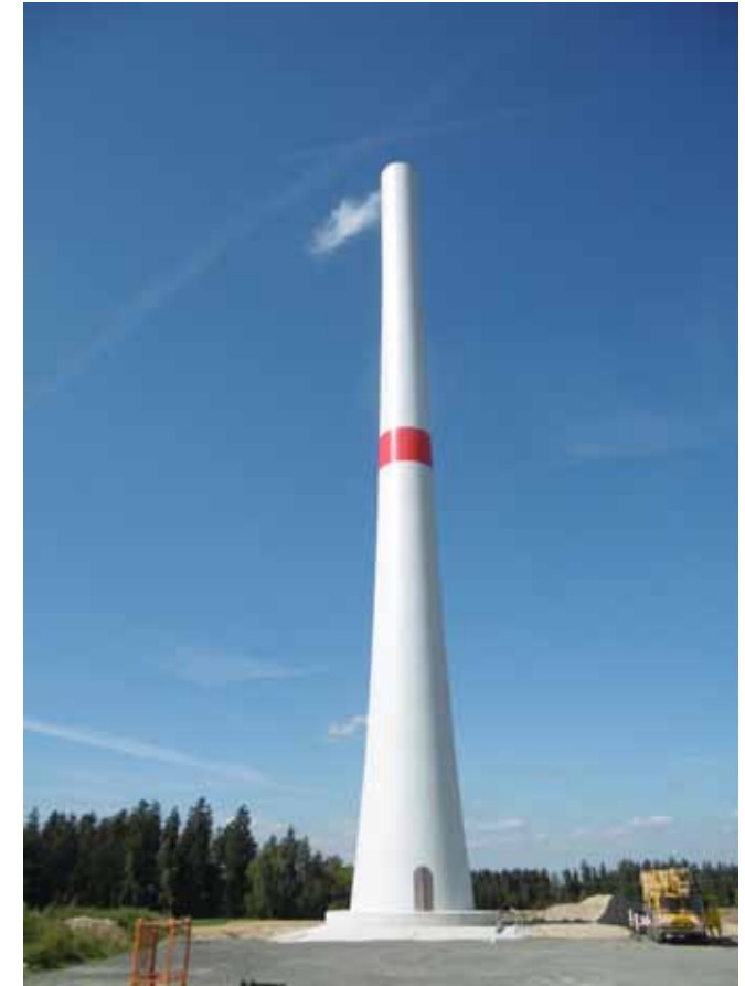
16.08.2016: fertiggestellter Beton- turm der WEA 4
