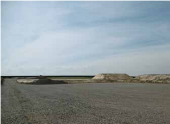
03.05.2016: fertiggestellte Kranstellfläche für die WEA 4
