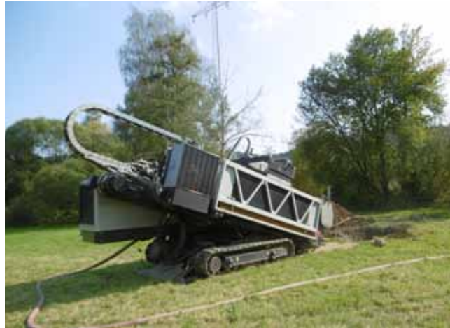
27.09.2016: Spülbohrung zur Querung der „Röslau“ kurz vor dem Umspannwerk am ehemaligen Kohle-Kraft- werksgelände Arzberg
