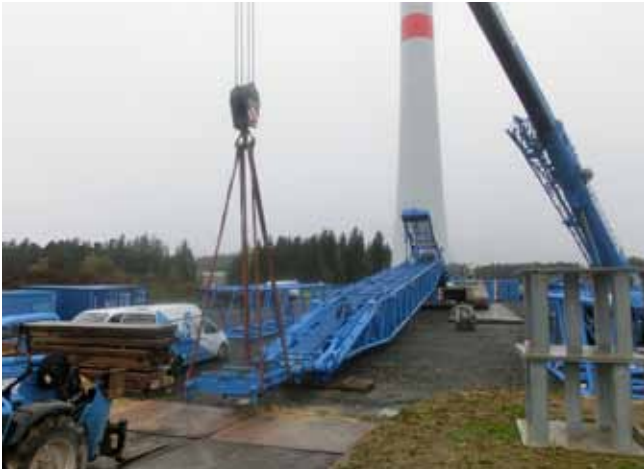
20.10.2016: Anlieferung des Groß- krans am Standort der WEA 4
