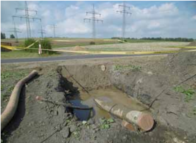
27.09.2016: Bohrung zur Querung der Kreisstraße WUN 18 im Bereich Oschwitz/ Arzberg
