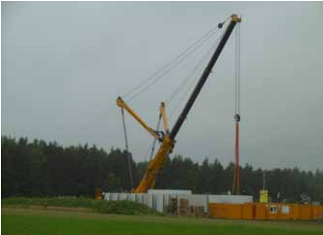
02.08.2016: Vormontage der ersten Turmteile (WEA 3)
