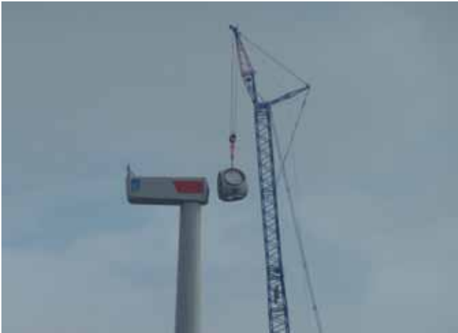
08.11.2016: Montage der Nabe (WEA 4) Hier werden anschließend die Rotorblätter ange- flanscht
