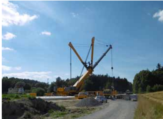
16.08.2016: Vorbereitungen für die Turmmontage am Standort 2
