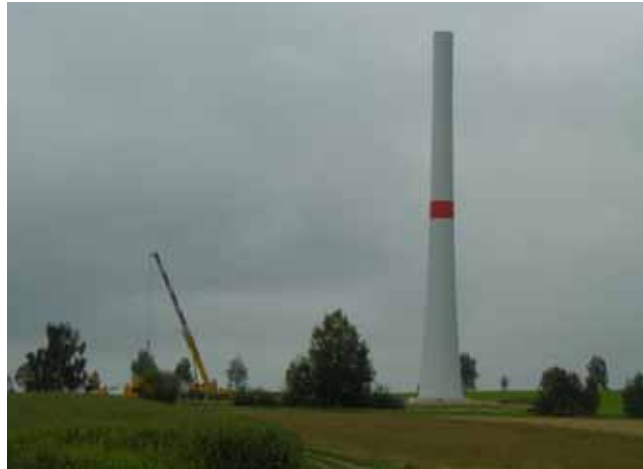
09.08.2016: fertiggestellter Betonturm von WEA 3
