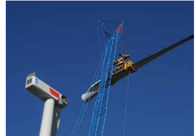
14.11.2016: Montage des zweiten Rotorblatts an WEA 4
