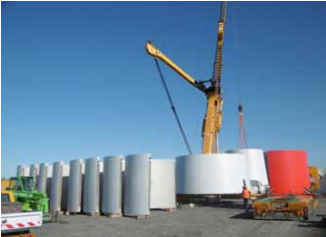
11.08.2016: Die Bauteile für die Turmsegmente der WEA 4 rücken an
