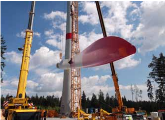
04.07.2014: Montage des ersten Rotorblattes
