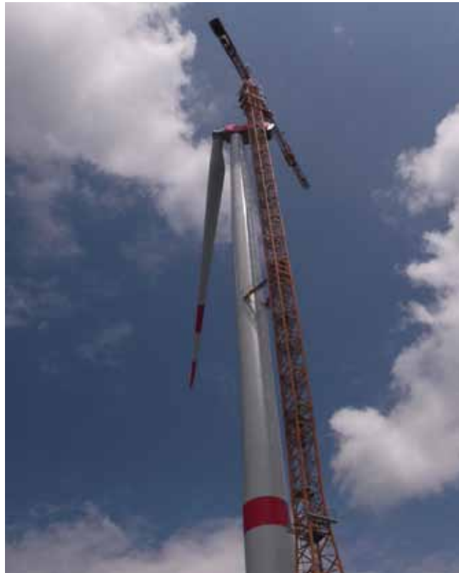
04.07.2014: Rotorblatt 1 ist montiert
