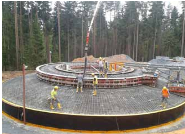
24.04.2014: 614 m 3 Beton sorgen für einen sicheren Stand des Windrads
