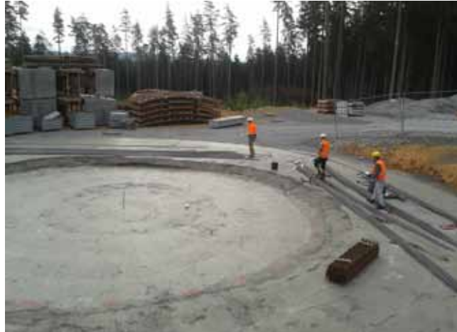
08.04.2014: Sauberkeitsschicht ist eingebracht. Nächster Schritt: Bewehrungsarbeiten
