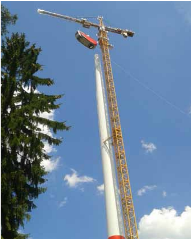
02.07.2014: Fast geschafft – nur noch einige Zentimeter und das Maschinenhaus „sitzt“
