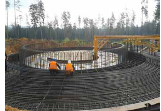
16.04.2014: Die Bewehrungs- arbeiten laufen. Insgesamt sind im Fundamentkörper 83 Tonnen Bewehrungs- stahl verarbeitet
