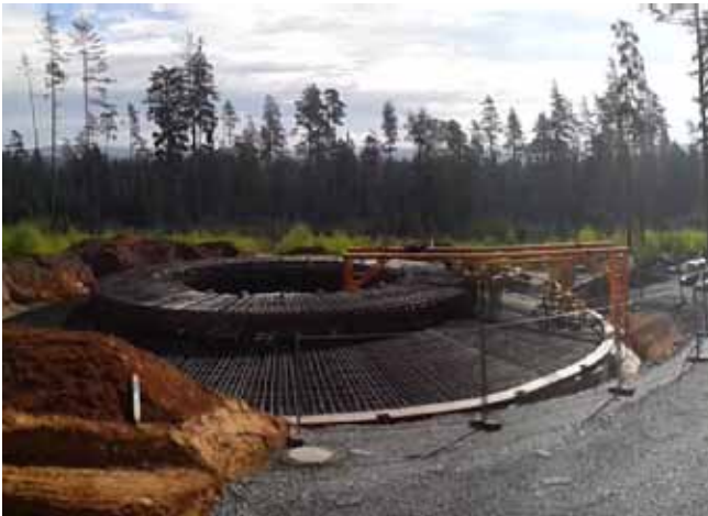
24.04.2014: Das erste Fundament wird betoniert
