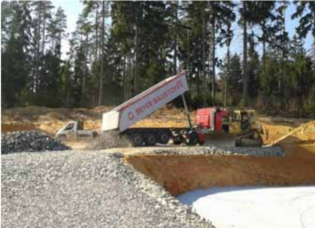
13.03.2014: Arbeiten an der Kranstellfläche
