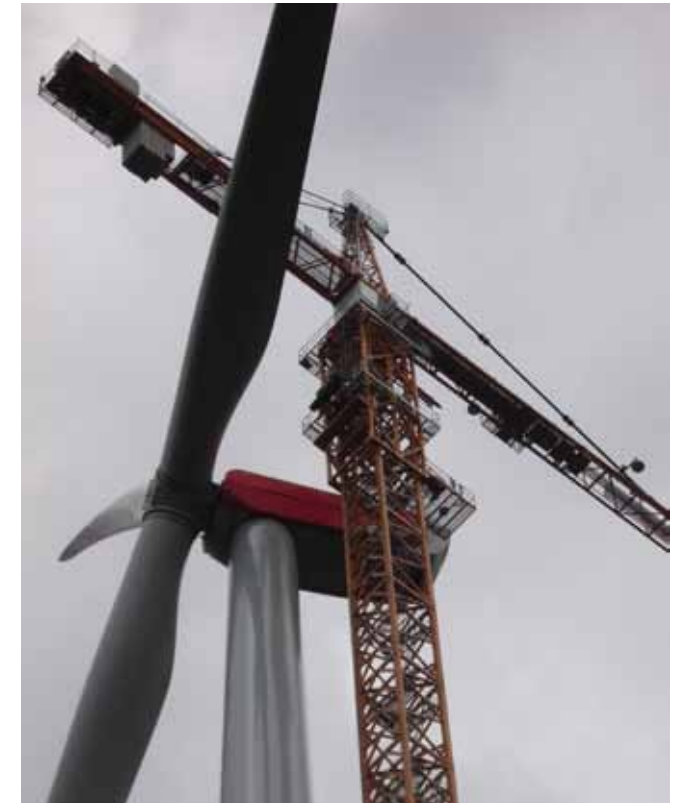
07.07.2014: Fertig ist der komplette Rotor
