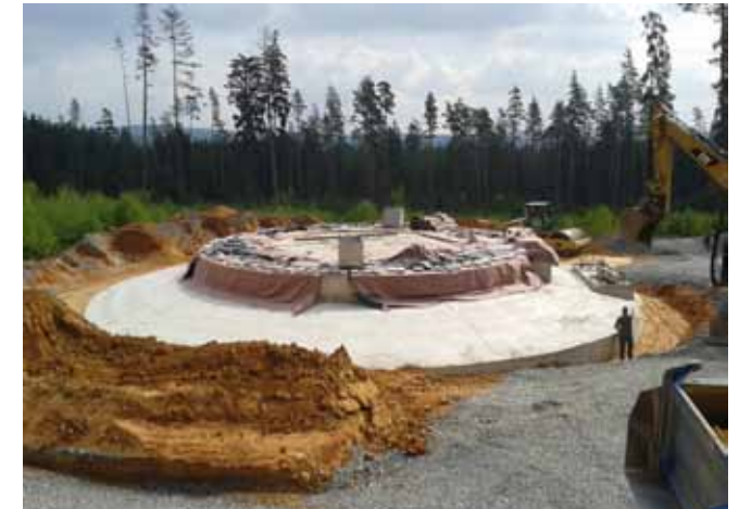
29.04.2014: Fertiges Fundament vor der Verfüllung mit Erdreich
