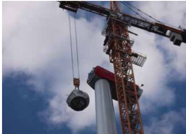
03.07.2014: Montage der Rotornabe
